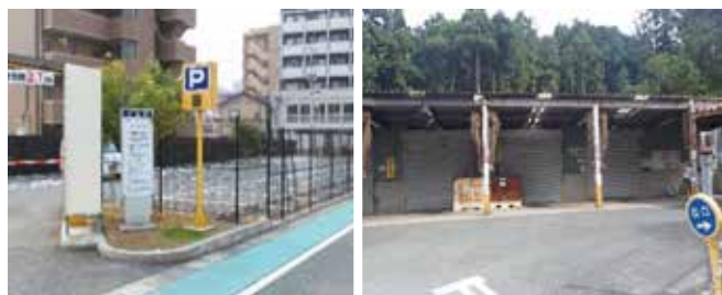
赤間駅北口駐車場 西側資源物受入施設
